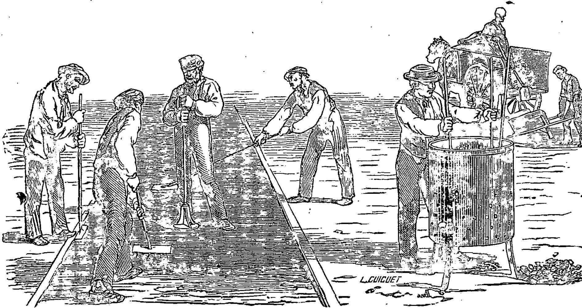
Fig. 189. — Établissement d'une chaussée en asphalte comprimé.
