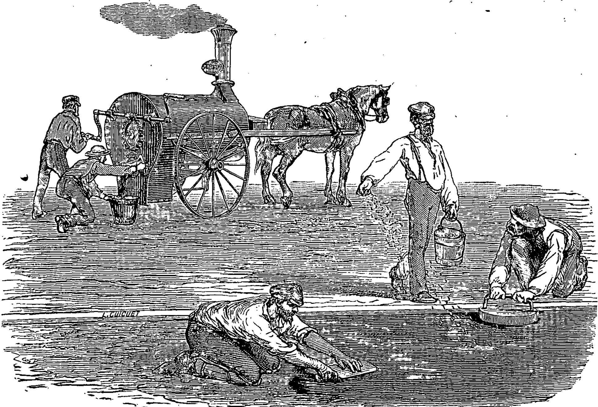
Fig. 191. — Établissement d'un trottoir en asphalte coulé, avec emploi des chaudières locomobiles pour la fusion du mastic d'asphalte.
