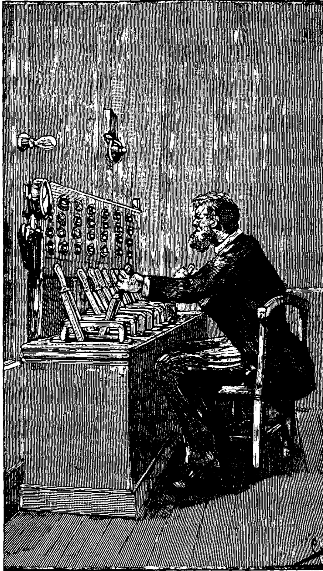
Fig. 533. — Kiosque de l'ingénieur conduisant les manœuvres.
